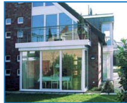
Fenster- und Fassadenbau
